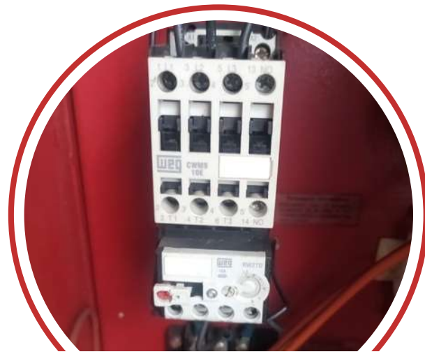
Instalación de tablero de control para bomba de combustión
