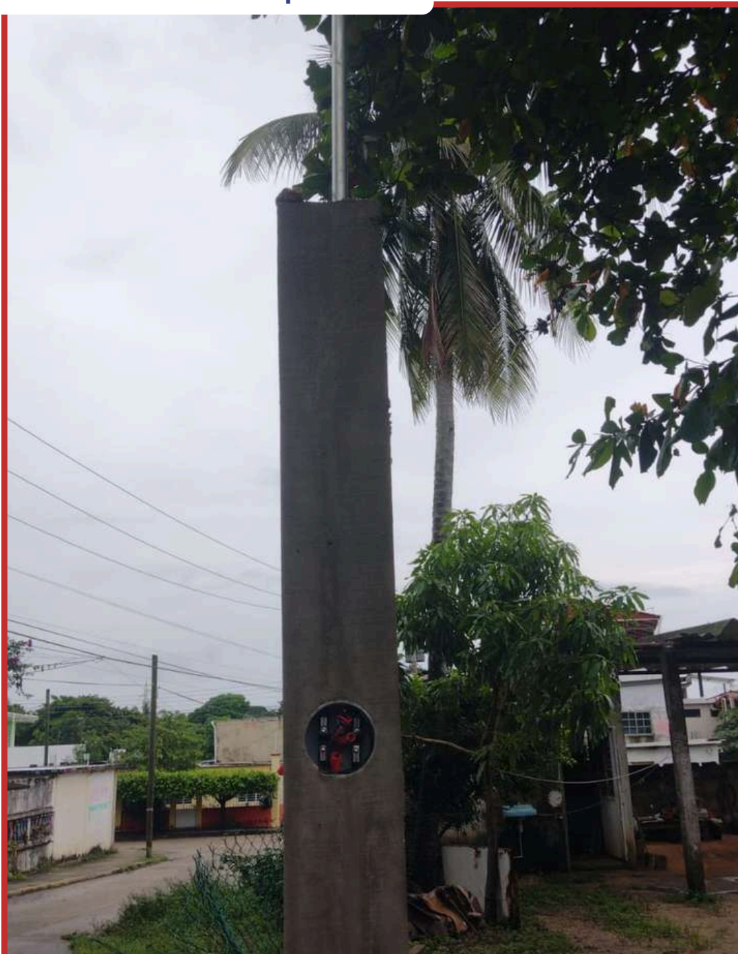
Construcción de murete para mufa
