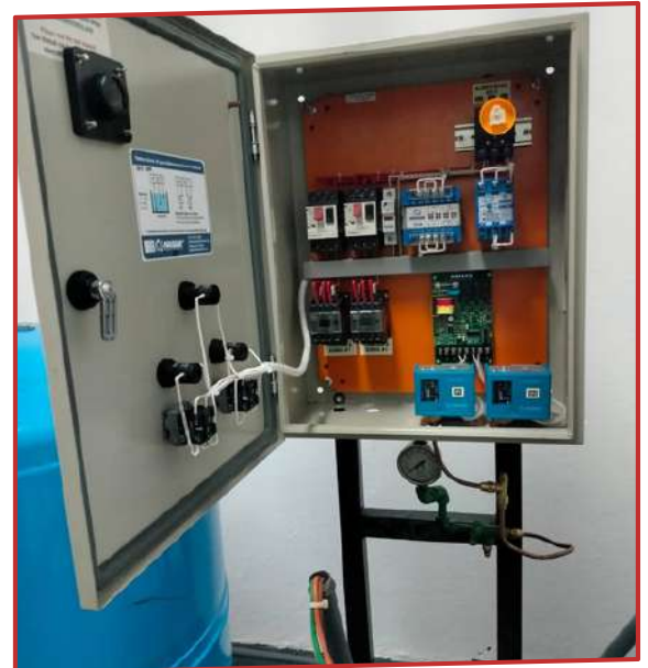
Suministro e instalación de ITM 3 polos 40 AMP 600 V
