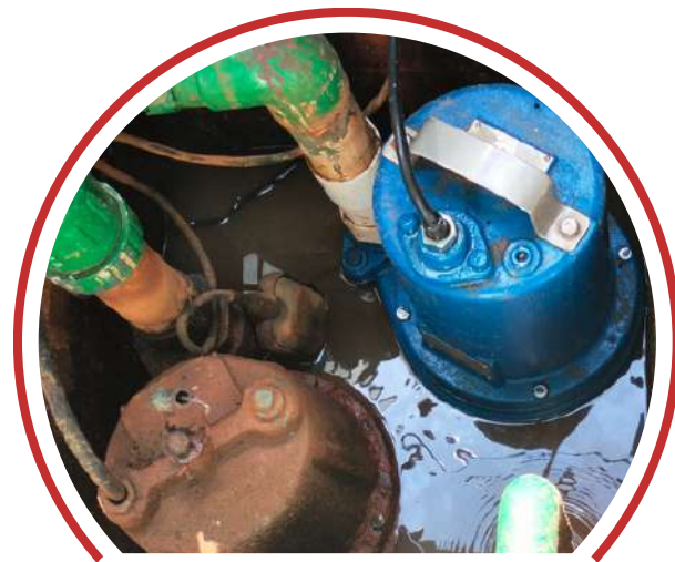
Instalación de bomba cárcamo
